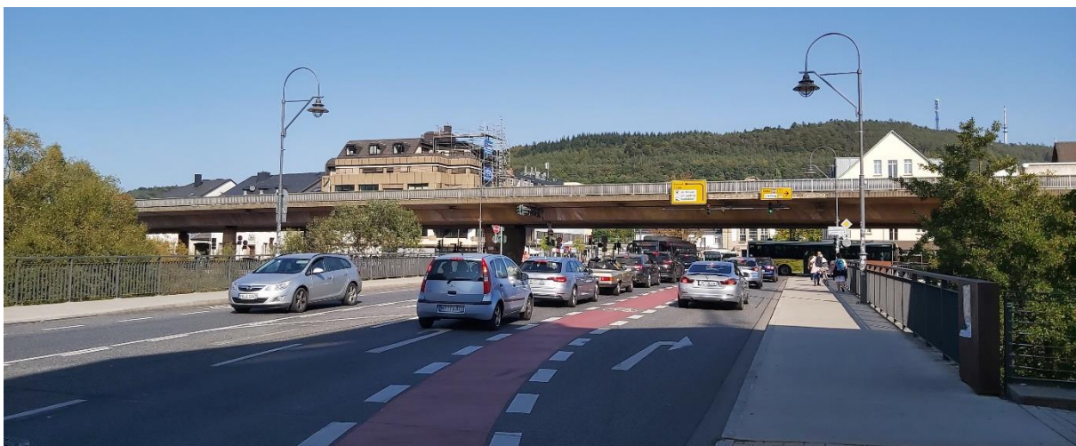
Abbildung 40: Vielbefahrener Abschnitt der Bahnhofstraße mit Blick auf die B3-Stadtautobahn
