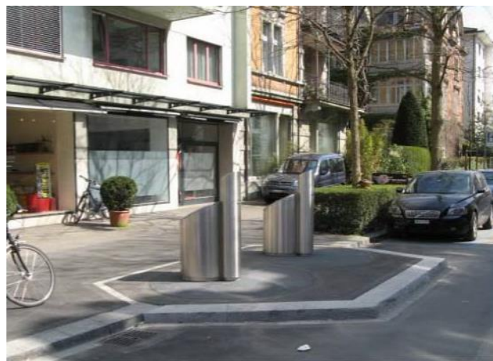
Abbildung 55: Unterflurmüllcontainer in Zürich (Basel 2013)
